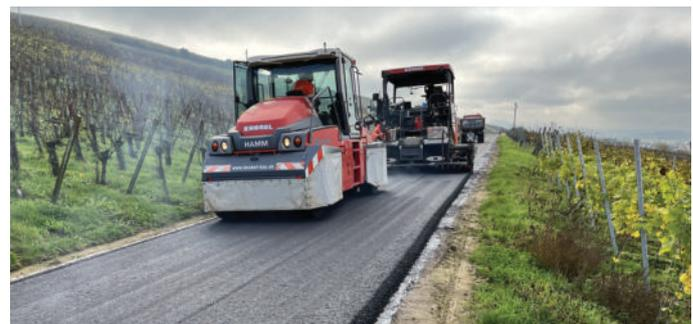
Nach Vorbereitung des defekten Untergrundes erhielt der Rebweg eine neue Tragdeckschicht. Die Kosten für die Sanierung belaufen sich auf ca. 60.000 € brutto.
