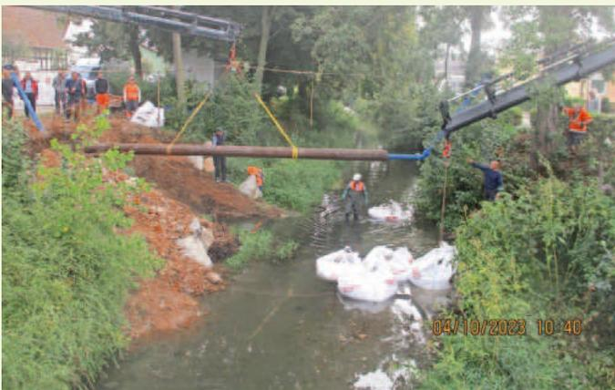
In diesem ersten Abschnitt wurde die Wasserleitung auf einer Strecke von ca. 145 Meter erneuert. Inbegriffen ist dabei auch der Düker (Querung der Möhlin). Dieses Rohrstück wurde vorgefertigt und mittels zweier Kräne in die Möhlin eingebaut.
