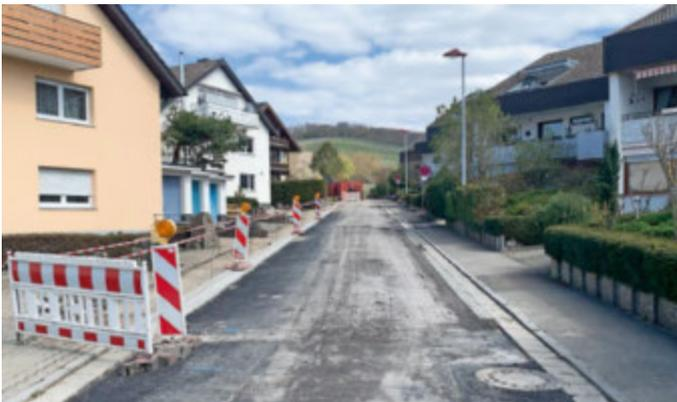
Die Fertigstellung des Straßenbelages erfolgte erst Ende September. Zuvor wurden noch die Leerrohre für das neue Glasfasernetz verlegt.
