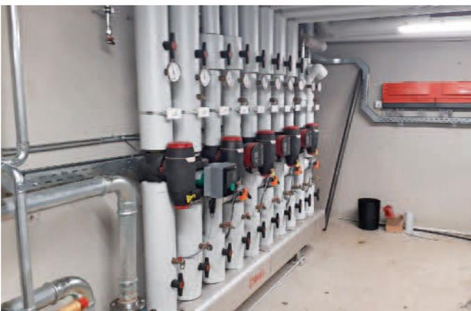
Die Gemeinde hat in diesem Zuge die Kalt und Warmwasserverteilung in einen angrenzenden Kellerraum verlegt und erneuert. Neue Umwälzpumpen und Mischventile wurden installiert und ein neuer Warmwasserspeicher mit 950 Liter eingebaut.
