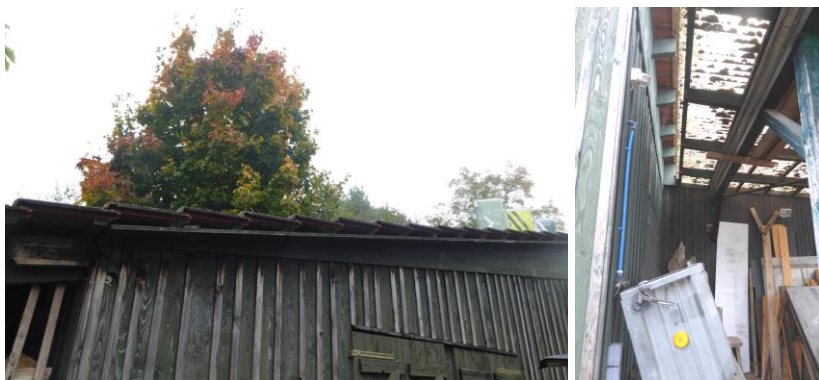
Abbildung 10: Gebäudestrukturen im Plangebiet (Fotos: galaplan decker)
