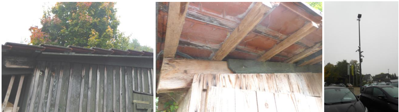
Abbildung 12: Gebäude-Untersuchung: Ziegelspalten an der Hütte, Licht-/ Fahnenmast (v. l. n. r.) (Fotos: galaplan decker)
