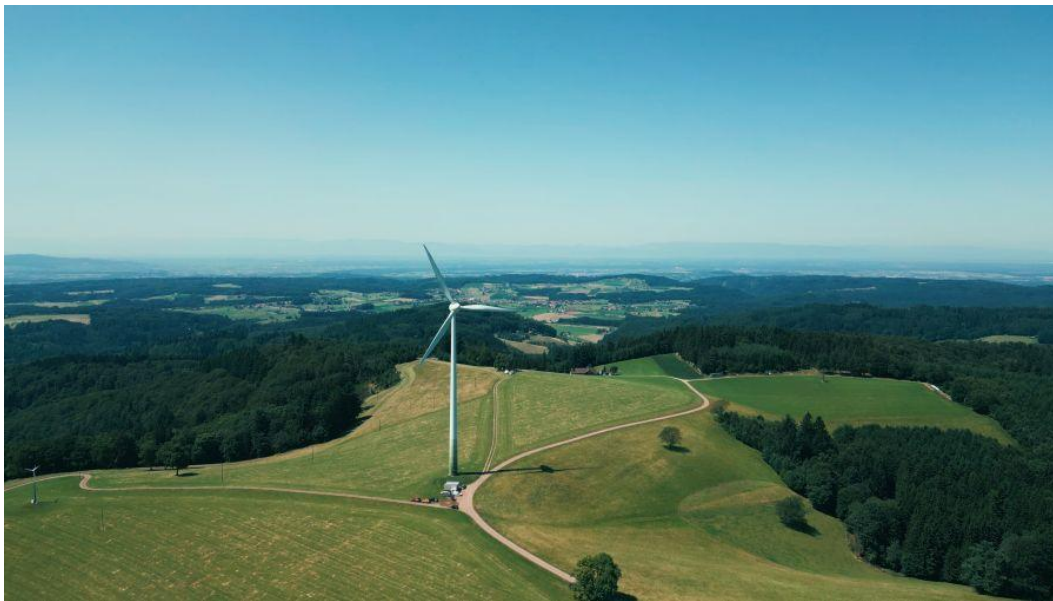
Windenergieanlage in Freiamt, Südbaden.
