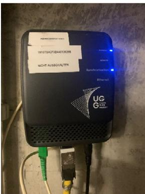
Optical Network Termination (ONT) – umgangssprachlich auch Glasfaserbox oder Glasfasermodem genannt – ist die Bezeichnung für den Abschlusspunkt des Glasfasernetzes im Haus. Die ONT-Box wandelt die Lichtsignale der Glasfaser in elektrische Signale um, die dann vom Router verarbeitet werden können. Sie stellt die Verbindung vom HÜP zum internen Netz dar und muss an das Stromnetz angeschlossen sein.
