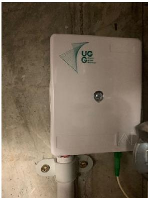
Der HÜP (Hausübergabepunkt) ist ein kompakter (weißer) Kasten, der von der UGG in der Regel an der Wand Ihres Hauses nach der Hauseinführung angebracht wird. Der HÜP ist die Verbindung des Glasfasernetzes mit der Hausinstallation.
