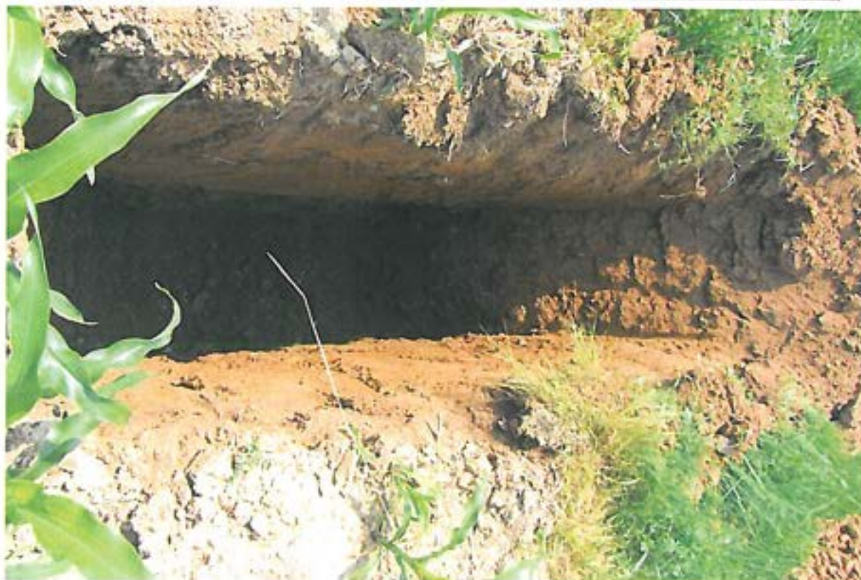
Bild 3: Das Bild zeigt beispielhaft den Untergrundaufbau anhand des Schurfs Z 10. Unter einem ca. 0,3 m mächtigen, schluffigen Oberbodenhorizont wurde bis in ca. 1,3 m Tiefe Lößlehm angetroffen (Schluff, tonig). Darunter steht bis zur Endtiefe von 2,5 m schluffig bis sandiger Kies mit vereinzelt Geröllen an.
