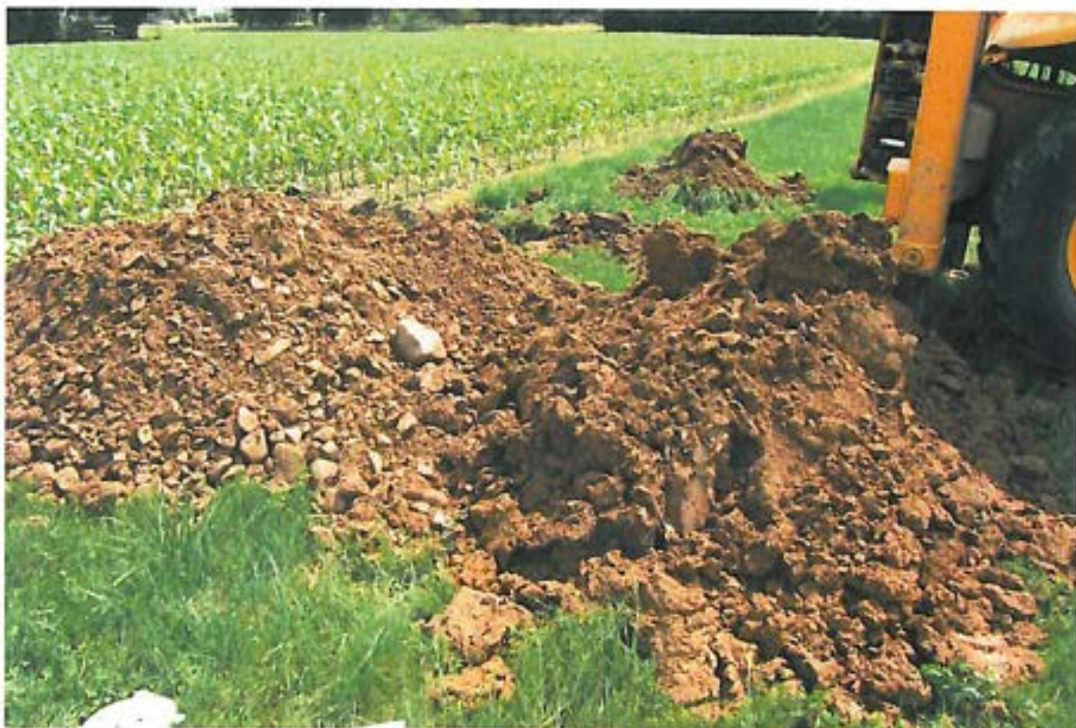
Bild 4 Aushub Schurf Z 10 - vorne links lagert der Kies, rechts der Lößlehm und im Hintergrund der ausgehobene Oberboden.
