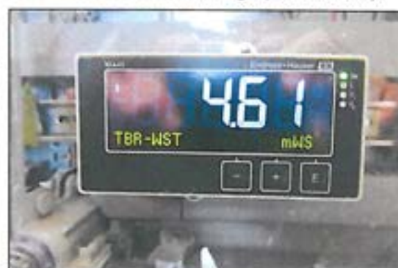
Bilder unten: Pumpwerk Kaibengässle mit digitaler Grundwasserstandsanzeige (Drucksonde)
